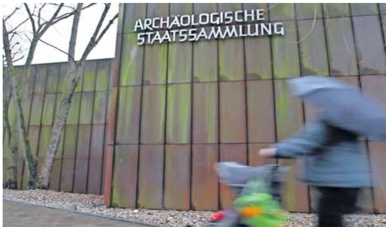
Gewollter Rost an der Fassade der Archäologischen Staatssammlung
